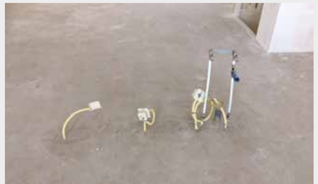
Aansluitpunten voor de keuken.
