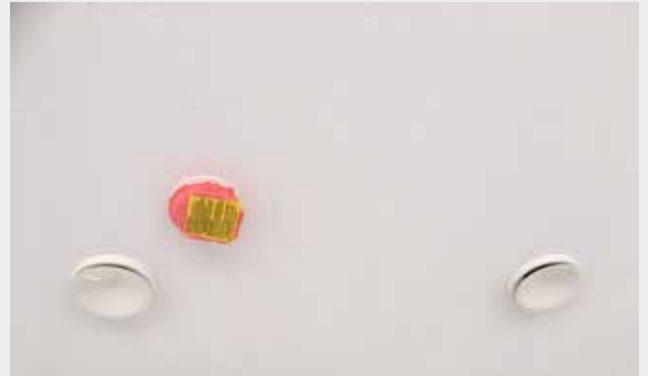
WTW ventielen en de rookmelder in het plafond.
