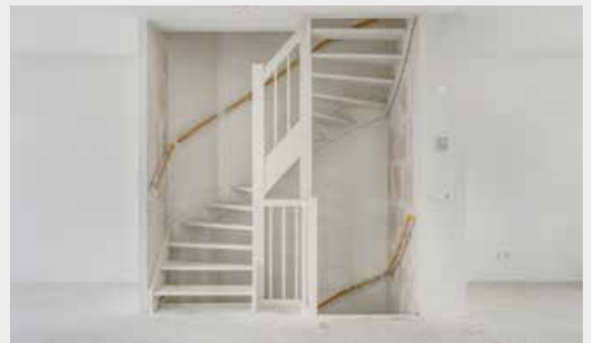
De trap kan licht beschadigd zijn door het lopen tijdens de bouw. Wij raden aan om de trap na oplevering nog te voorzien van een afwerking in de vorm van verf of bekleding.
