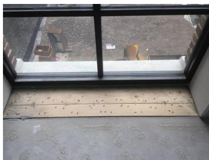
Voorbeeld vloerovergang dekvloer-stelkozijn
