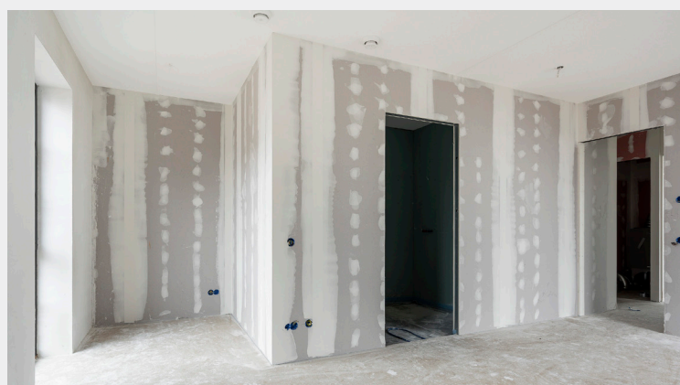
Afwerking van metal stud binnenwanden
