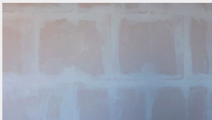
Behangklare afwerking van de gipsblokken.
