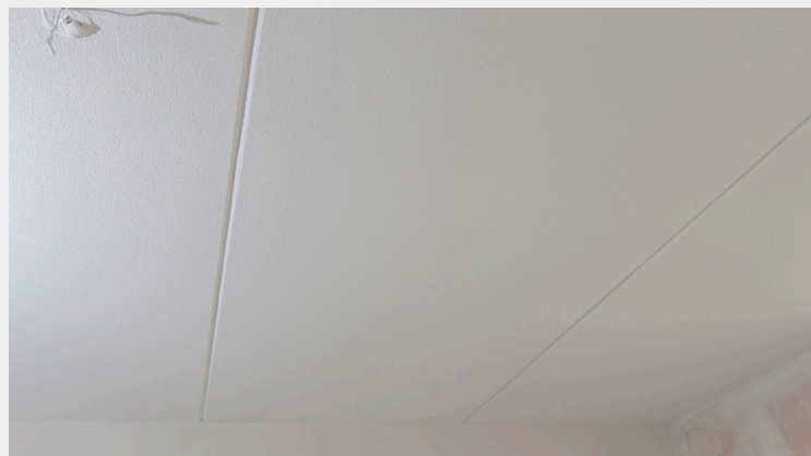
Spuitwerk op het plafond met zichtbare V-naden.
